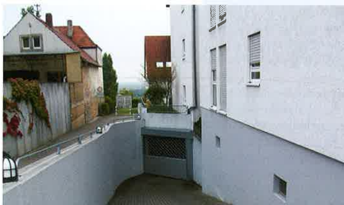
If accommodation exists in the immediate vicinity of the door, adequate noise insulation must be provided for | Liegt in unmittelbarer Umgebung des Tores Wohnraum, muss für einen angemessenen Schallschutz gesorgt sein
